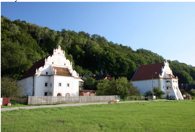
Spichlerze Przybyłów - Stan z przed remontu.
